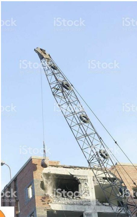
Questo procedimento di demolizione si basa su di una serie di impatti ripetuti esercitati sulla struttura utilizzando una grossa palla metallica (“wrecking ball”); quest’ultima viene sospesa ad **un** cavo, il quale la fa agire sotto un movimento pendolare, ovvero per caduta verticale, l’impatto è del tipo che caratterizza anche l’azione dei piloni.
