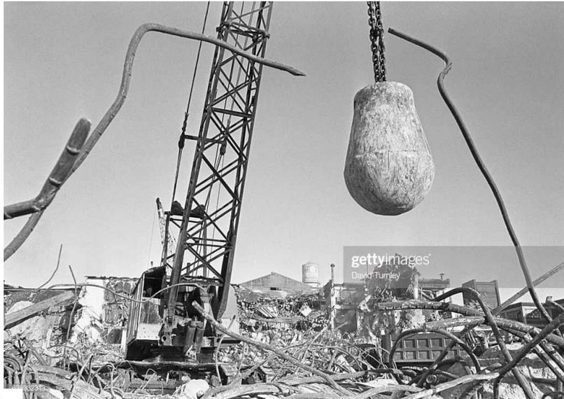
Inoltre le stesse valutazioni sulla posizione del centro di pressione, fatte nel caso della demolizione per spinta, sono egualmente valide anche nel caso della demolizione effettuata con la palla demolitrice: bisogna infatti prestare attenzione a **non attaccare con un'azione orizzontale la base di un elemento verticale**, poiché ciò causerebbe il ribaltamento della parte superiore dell'elemento, proprio nella direzione dell'operatore.
